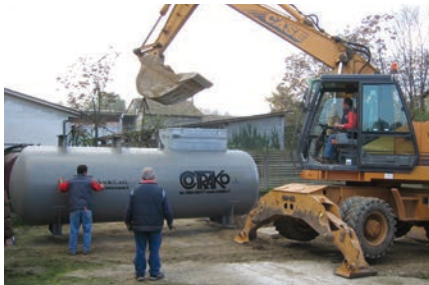
Trasporto e scarico nello scavo con gru Delivery and unload in the hole with crane
